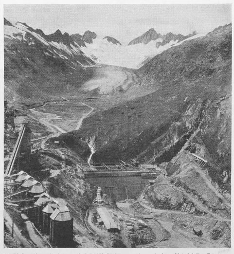
Bild 42. Das Oberaarbecken am 19. Juli 1952. Links, von unten nach oben: Materialsilos, Betonturm und Baggerfeld  ${}^{\prime}$
