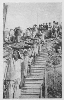
Bild 5, Primitiver Betontransport beim Bau der Tilaija-Staumauer (Damodar Valley Corp.), 21, Jan. 1951
