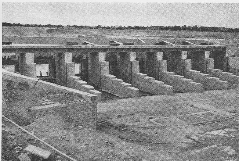
Bild 7. Einlaufbauwerk für den Umleitungskanal am Nangal-Stauwehr
