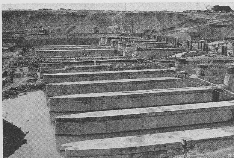
Bild 8. Nangal-Stauwehr im Bau
