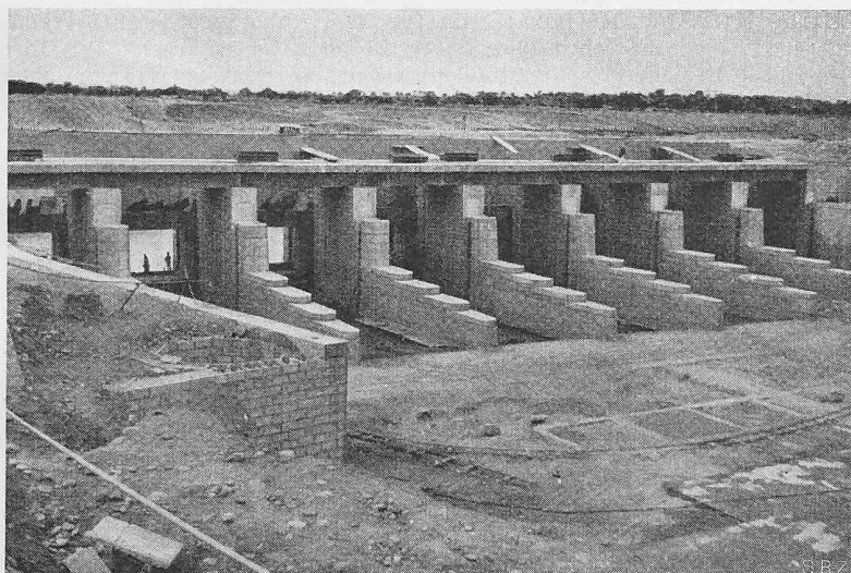
Bild 7. Einlaufbauwerk für den Umleitungskanal am Nangal-Stauwehr
