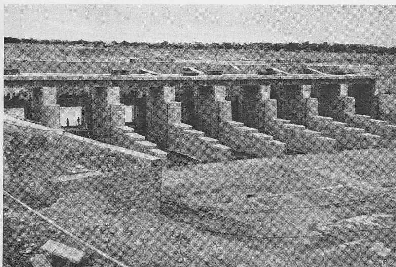
Bild 7. Einlaufbauwerk für den Umleitungskanal am Nangal-Stauwehr
