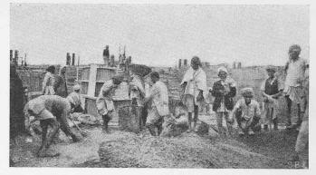
Bild 4. Betonherstellung von Hand beim Bau des Nangal-Stauwehrs, 18. Jan. 1951
