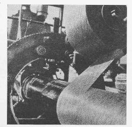
Bild 1. Isolation der 250 km langen Oelleitung Le Havre—Paris mittels einer automatischen Perrault-Maschine
