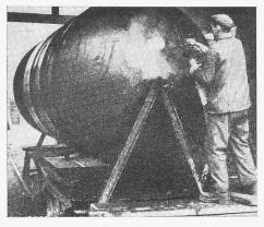
Bild 5. Benzin- und Oeltanks werden mit «Veroid»-Glasgewebe und «Shellpipe»-Heissbitumen isoliert (Meynadier & Cie. AG., Zürich)
