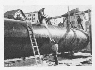
Bild 8. «Vetro-Waberit»-Isolation eines der zwei 150 000 Liter-Oelbehälter der Stadt Le Locle (Strassenbaumaterial AG. Bern)
