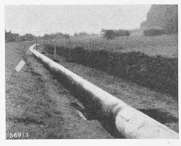
Bild 6. Neue Leitung für die Wasserversorgung der Stadt Biel; Rohre mit Glasvlies (Sulzer), Stosstellen mit «Vetrotex»-Band isoliert (O. Wild AG., Muri/
