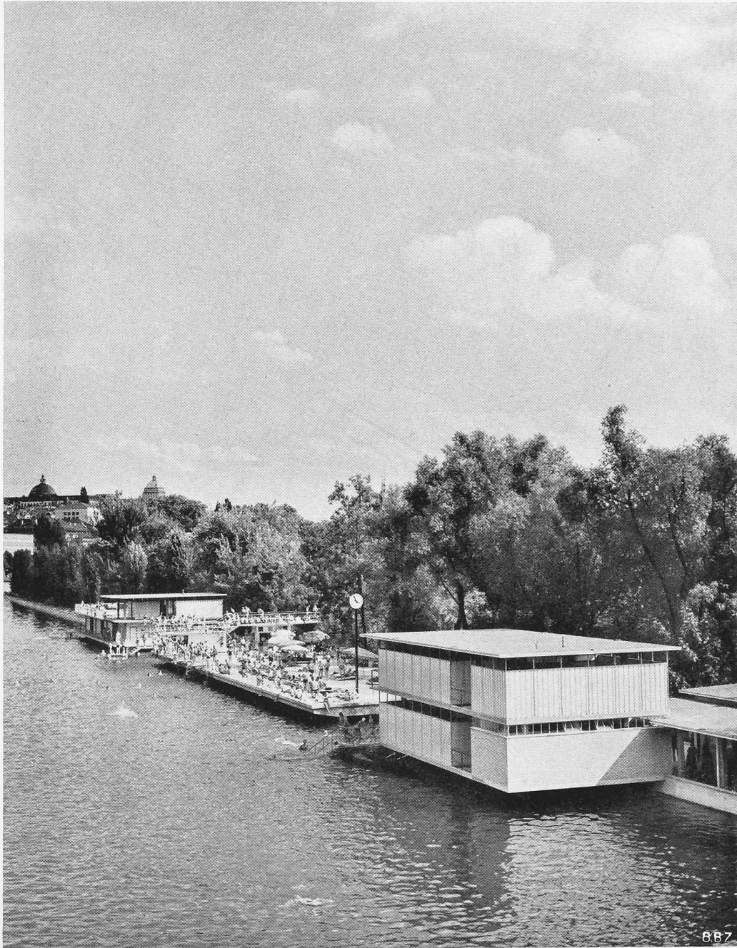
Bild 4. Ansicht von der Kornhausbrücke flussaufwärts
