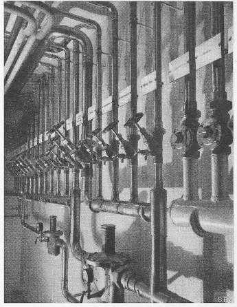
Bild 31. Verteilbatterie, Kupferinstallation
