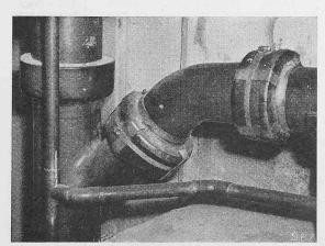
Bild 32. Steinzeug-Ablaufrohr, Detail der Dichtung
