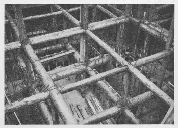
Bild 19. Baugrubenspriessung Turmfundament
