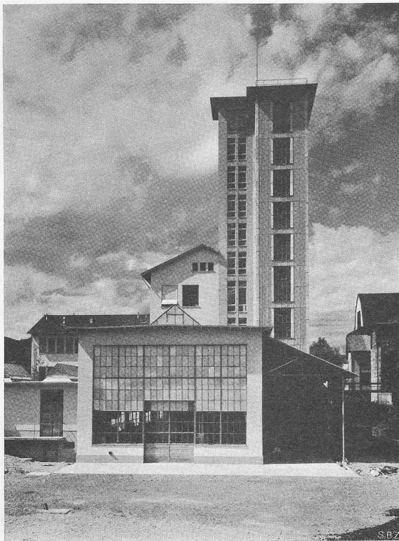
Bild 16. Turm und Werkstatt aus Nordosten
