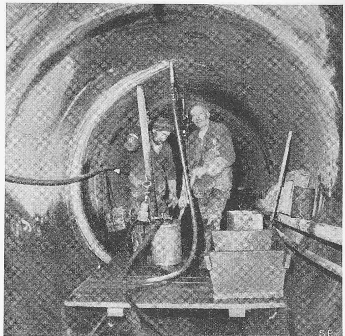
Bild 16. Druckschacht; Zementinjektionen
