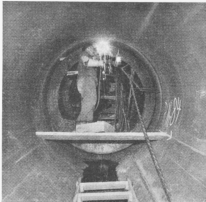
Bild 14. Druckschacht; Schweiessen der Panzerung
