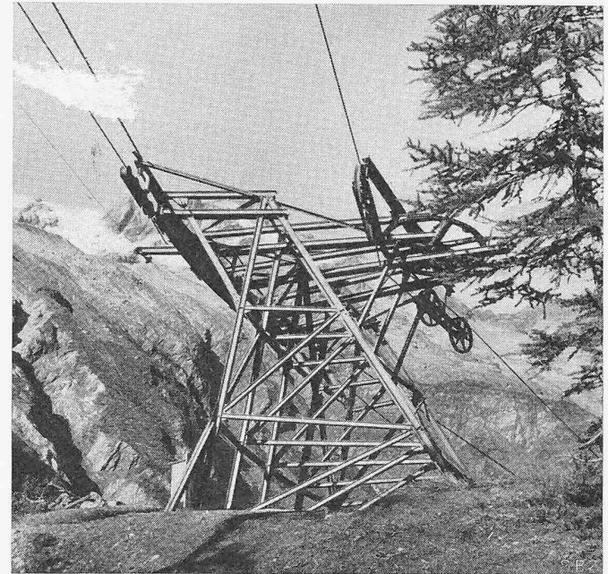
Bild 3. Winkelmast der Gauliseilbahn
