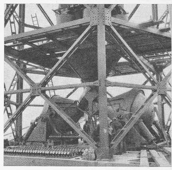
Bild 6. Staumauer Rätherichsboden, Betonmischturm System Johnson; oben automatische Waagen, unten 3 m $^3$ -Betonmischer.
