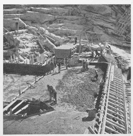
Bild 8. Staumauer Rätherichsboden, Betonierung, Vibration mit Zweimannvibratoren
