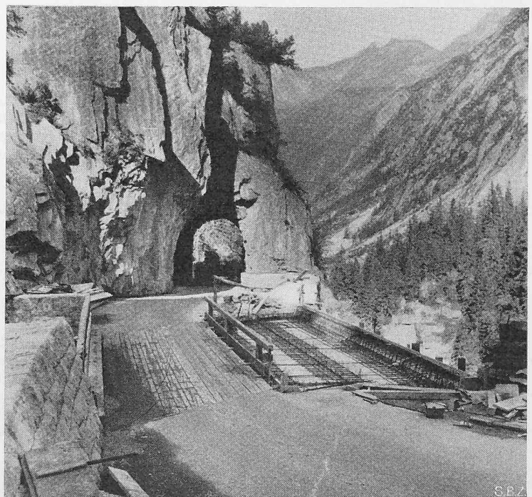
Bild 2. Korrektur der Grimselstrasse, Brücke mit vorgespannten Eisenbetonbalken
