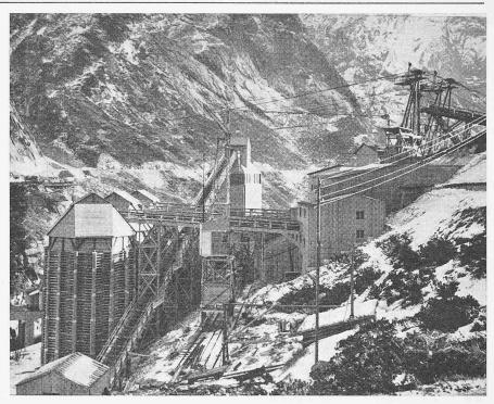
Bild 7. Staumauer Rätherichsboden. Rechts Kiesaufbereitungsanlage. Links Abtropfsilos. Mitte Transportband und Betonmischturm
