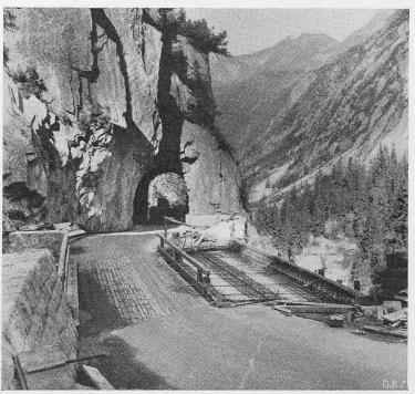
Bild 2. Korrektion der Grimselstrasse, Brücke mit vorgespannten Eisenbetonbalken
