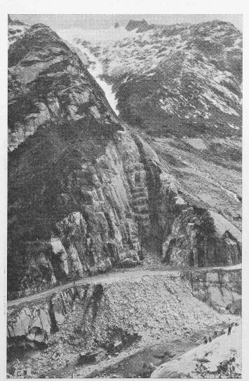
Bild 4. Felsausbruch des rechten Maueranschlusses; im Hintergrund der Gerstenbach
