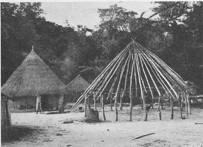
Bild 1. Zentralafrikanischer Pavillon im Bau
