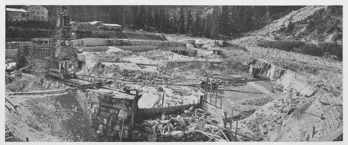
Bild 35. Ausgleichweiher Handeck, Umfassungsmauer aus Blockbeton. Bauzustand am 30. September 1946
