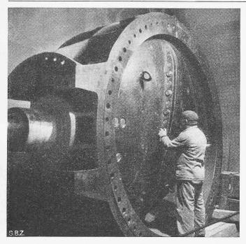
Bild 25. Die Drosselklappe,  $\, \phi \,$  270 cm, im Wasserschloss Handeckfluh
