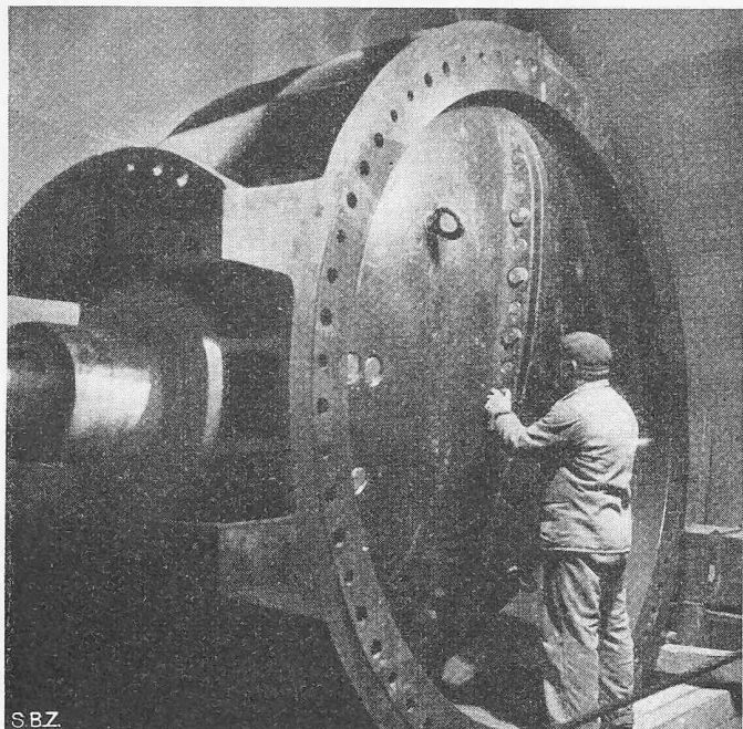
Bild 25. Die Drosselklappe, \varnothing 270 cm, im Wasserschloss Handeckfluh
