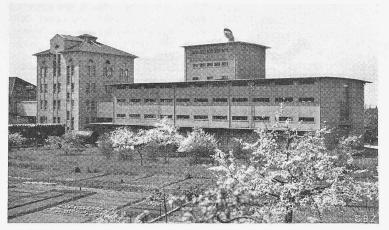
Bild 8. Extraktionsgebäude, Lagerhaus mit Schrotkühl- und Mahlanlage, gesehen von Nordosten
