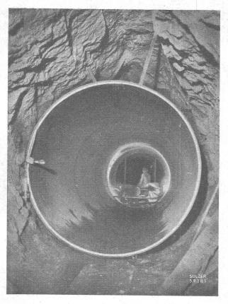
Druckschacht-Panzerrohr in Montage. Durchmesser 2,2 m. Betriebsdruck 33 at.
