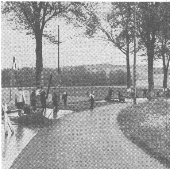
Einbau eines CARPAVE-Teppichs
