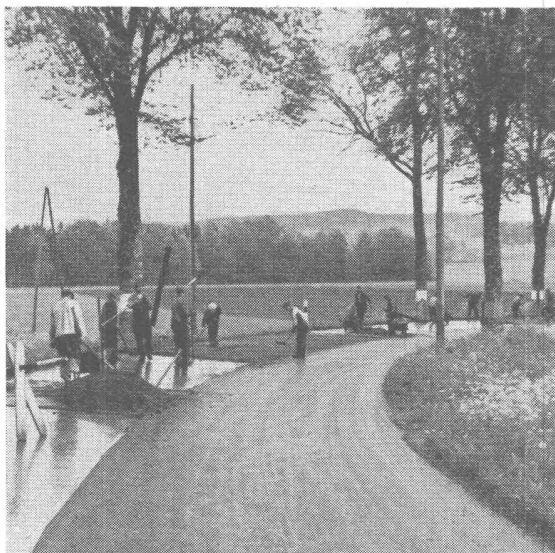
Einbau eines CARPAVE-Teppichs
