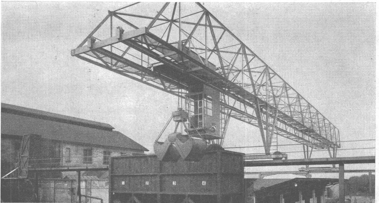
Verladebrücke in Schweisskonstruktion 2,5 t Tragkraft, 46 m Länge
