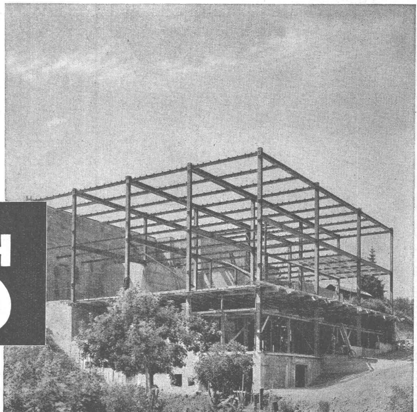
Stahlskelett für Fabrikneubau
