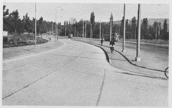
Bilder 10 und 11. Erhöhte Radwege. Die Stufen engen den Radweg ein und können gefährlich werden. Der Radfahrer zieht es vor, wenn die Polizeiaufsicht fehlt, auf der Fahrbahn zu fahren. Heller Belag in Bild 10.
