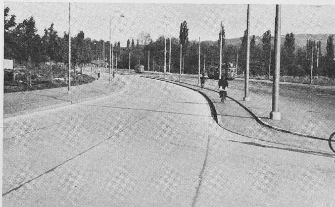
Bilder 10 und 11. Erhöhte Radwege. Die Stufen engen den Radweg ein und können gefährlich werden. Der Radfahrer zieht es vor, wenn die Polizeiaufsicht fehlt, auf der Fahrbahn zu fahren. Heller Belag in Bild 10.
