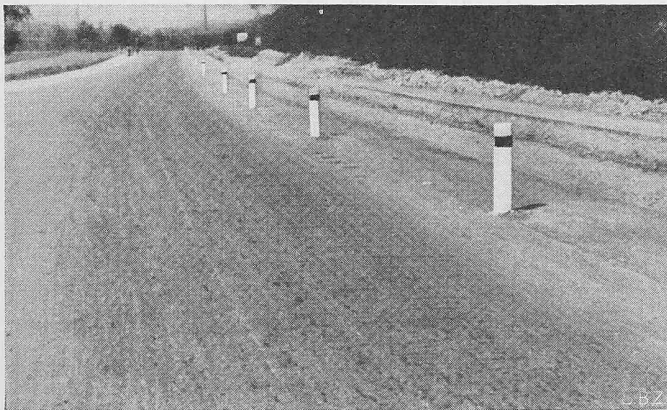
Bilder 8 und 9. Radstreifen durch Pforten von der Fahrbahn getrennt. Hat sich nicht bewährt, die Pforten sind durch eine optische Markierung ersetzt worden (Bild 9).
