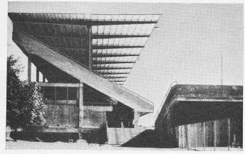
Bild 38. Haupttribüne im Fussballstadion Stockholm-Rasunda, Eisenbetonbau, Stahlsäulen  $\phi$  27,5 cm, DIP-Pfette, geschweisste Profilbalken, Holzdach (vgl. SBZ Bd. 118, S. 184\*). Arch. SVEN IVAR LIND und B. BORGSTRÖM.
