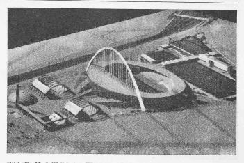
Bild 32. Modellbild des Wettbewerbentwurfes für das Olympiastadion in Rio de Janeiro. Das Tribünendach wird von Stahlseilen gehalten, die an einem weitgespannten Eisenbetonbogen hängen. Grundriss siehe Bild 14 [5]. Arch. O. NIEMEYER.
