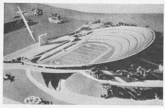
Bild 31. Projekt für ein Sportzentrum von LE CORBUSIER, 1936/37. Je nach dem Sonnenstand können Sonnensegel an Drahtseilen aufgezogen werden, die an einem zentralen Mast befestigt sind. 100 000 Plätze [5].
