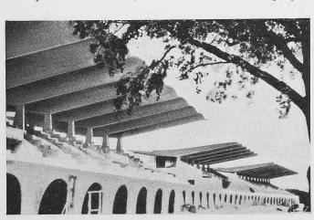
Bild 36. Tribünen der Pferderennbahn in Madrid, Kühne Schalenkonstruktion, Spannweite 12,80 m, Schalenstärke 5 cm [5].
