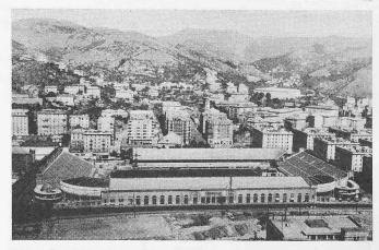
Bild 5. Fussballstadion in Genua mit Rundrampen, Neue Tribüne 1950,  $45^{\circ}$  Neigung, 70 000 Plätze, Ing. A. VICARI [4].
