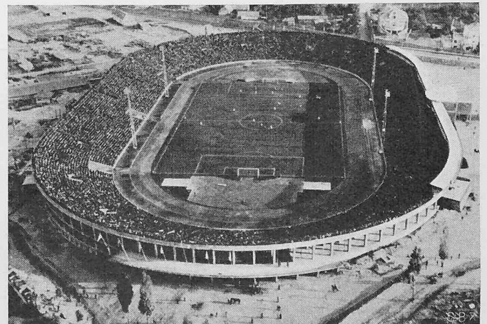
Bild 19. Partisanstadion in Belgrad, 1951. Einstöckige Anlage mit inneren Rampen. 60 000 Plätze, Ing. JANKOWIC und POPOVIC.
