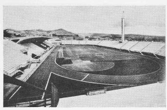
Bild 33. Uebersichtsbild des Stadions von Florenz, D-förmiges Spielfeld mit Kurzstreckenbahnen von 220 m Länge, Elegantes Eisenbetondach mit stark zurückgesetzten Stützen, Ing. P. L. NERVI [1].
