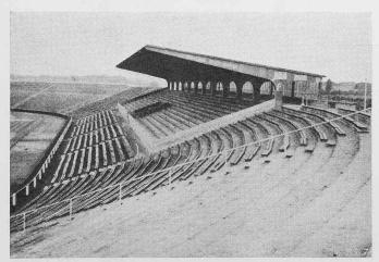
Bild 18, Stadion in Ludwigshafen (Rheinland), 1951, Erdwallbauten und Stahlkasten-Träger-Tribünendach (Photo Verfasser).
