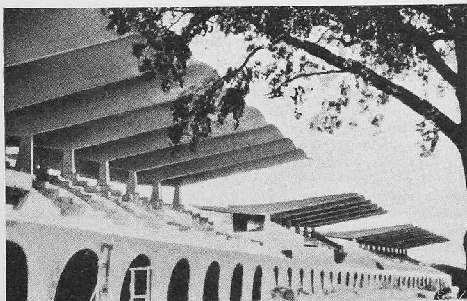
Bild 36. Tribünen der Pferderennbahn in Madrid. Kühne Schalenkonstruktion, Spannweite 12,80 m, Schalenstärke 5 cm [5].
