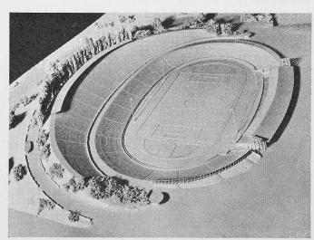
Bild 41. Projektiertes Stadion Hannover, Modellphoto. Unterer Teil versenkt, Hauptwall aus Trümmern aufgeschüttet. Klare Verkehrsführung. Arch. Prof. R. KONWIARZ mit städt. Bauverwaltung Hannover, Mitarbeiter Dipl. Ing. GOESMANN.
