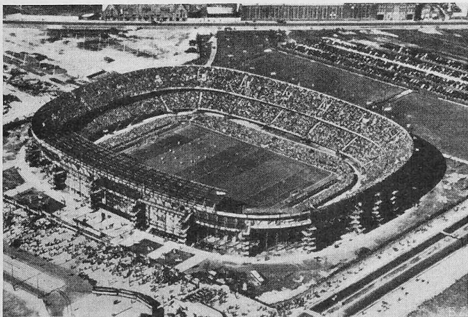
Bild 21. Flugbild des Rotterdamer Stadions, Rings um die Anlage Parkierungsflächen, eigene Bahnstation und Trambahnstation [3].
