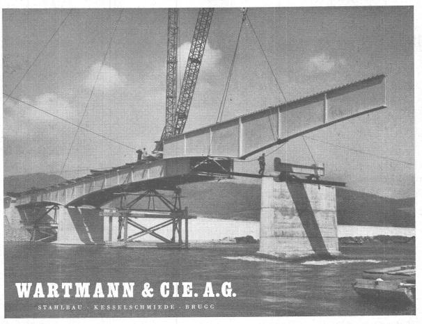
Montage der neuen geschweissten Brücke über die Aare bei Schinznach-Bad
