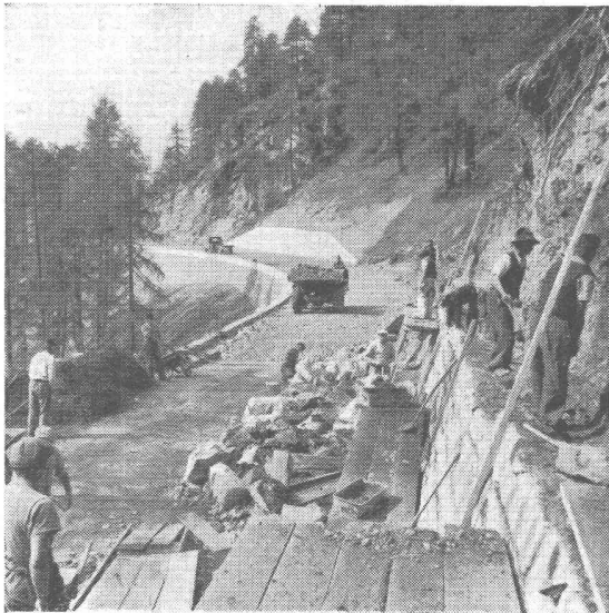
Verlegung der Julierstrasse in Marmorera
