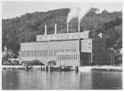
Bild 4. Das Dampfkraftwerk Dieppedalle (Nordfrankreich), mit vier Kesseleinheiten, von denen je zwei mit je einer 50 000 kW-Turbogruppe zu einem Block vereinigt sind. ImVordergrund die Seine, längs dem Ufer das Maschinenhaus, dahinter das Kesselhaus.
