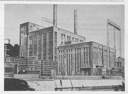
Bild 2. Das Dampfkraftwerk Monceau (Belgien) mit zwei Einheiten in Blockschaltung zu je 50 000 kW. In der Mitte das Kesselhaus für zwei Einheiten, links das Hochhaus für die Kohlenstaub-Aufbereitung, rechts das Maschinenhaus.
