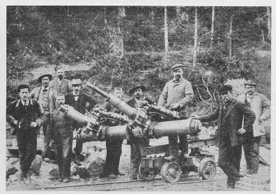
Bild 1. Druckwasser-Bohrmaschine, System Brandt, in Preda.
