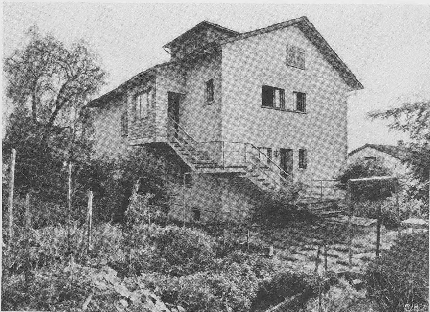
Ansicht der Aussentreppe Rotfluhstrasse 17
