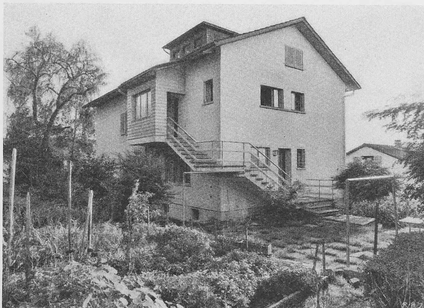
Ansicht der Aussentreppe Rotfluhstrasse 17
