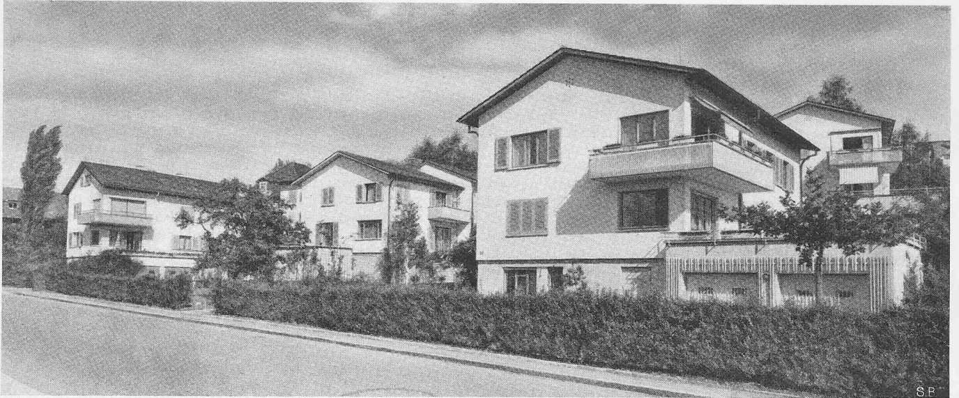
Gesamtansicht aus Westen
