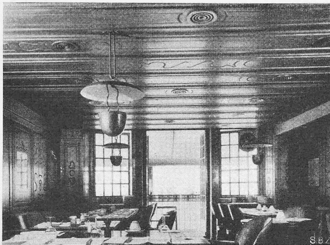
Bild 35. Blick in die Gaststube mit Lüftung nach Bild 32.
