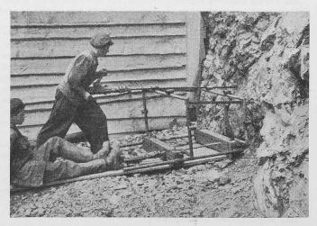
Eild 28, Bohrschablone bei Brennereinbruchversuchen des Verfassers (Bild 23b) im Dolomit des Achenseestollens
