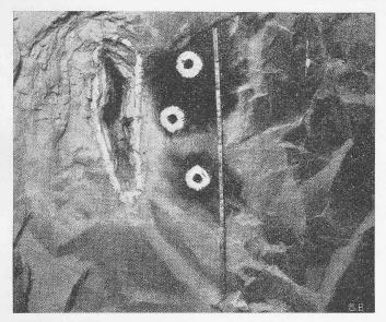
Bild 25. Brennereinbruch im Granit gemäss Bohrbild 23c nach Abschiessen der Zündstufen 0 und 1
