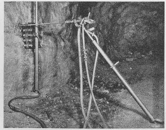
Bild 27. Bohrschablone für Brennereinbruch gemäss den Bildern 25 und 26
