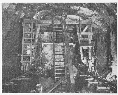
Bild 17. Schwedischer Bohrwagen mit zwei Arbeitsbühnen, auf Gleisen fahrbar (Bilder 15 und 17 Photo Atlas Diesel)
