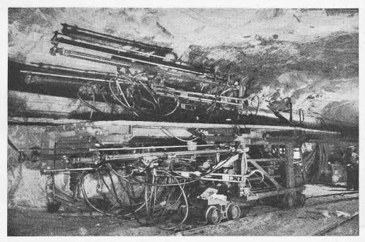
Bild 12. Boomjumbo, wie Bild 11, mit sechs Bohrmaschinen DA 30.
