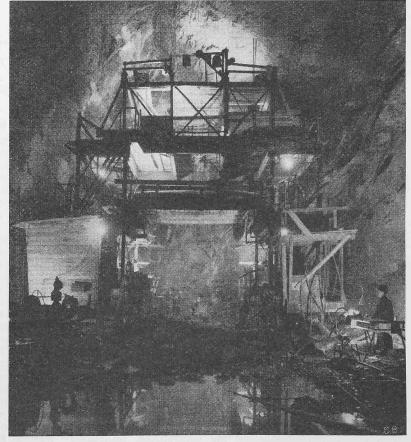
Bild 18. Bohrgerüst beim Bau der Tunnels des Hjältakraftwerkes in Schweden.  $F=130~\mathrm{m^2}$  (Photo Atlas Diesel)
