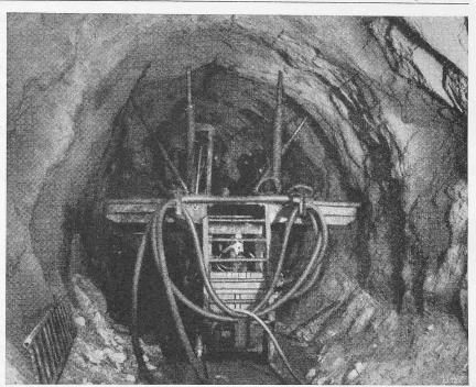
Bild 11. Boomjumbo Ingersoll Rand beim Vortrieb der 18 m $^2$ -Stollen des Maggiawerkes, mit Podium für die obere Hälfte. Verspannung gegen den Berg mit vier Dornen
