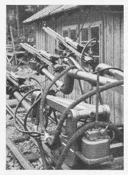
Bild 10. Höhenverstellvorrichtung für die Bohrarme des Wagens Bild 9
