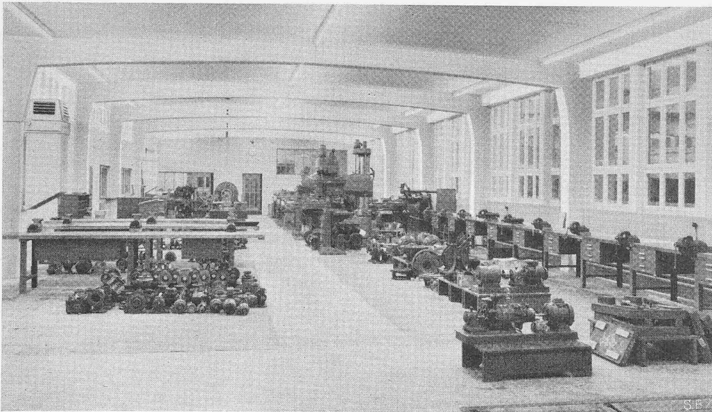
Bild 12. Blick in die Werkhalle, im Vordergrund der Pumpenprüfstand
