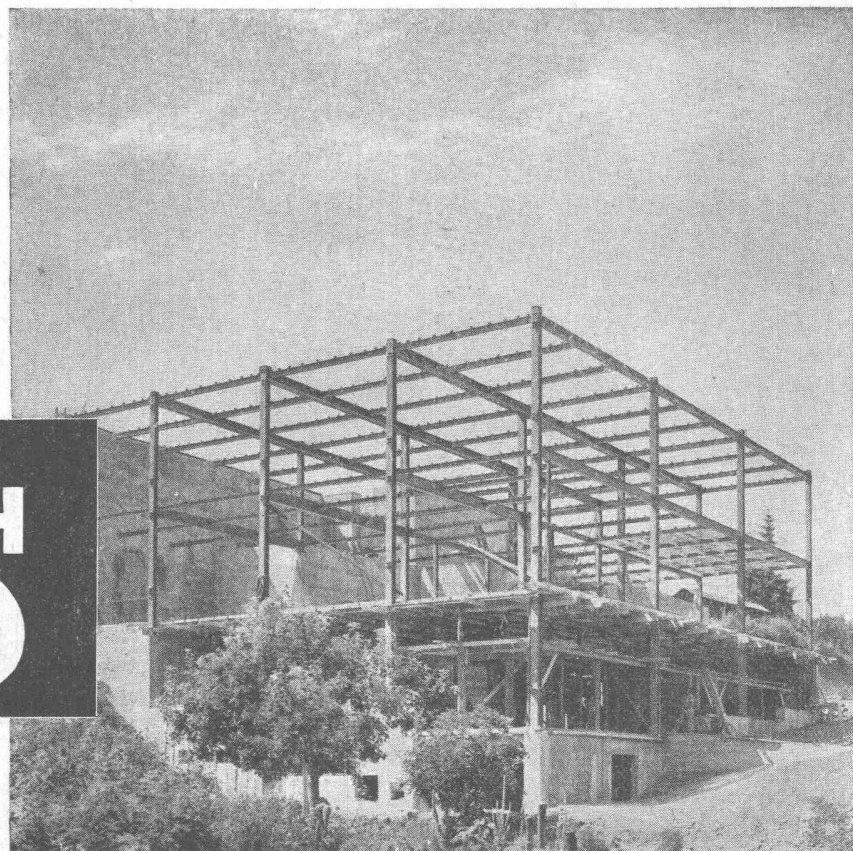
Stahlskelett für Fabrikneubau
