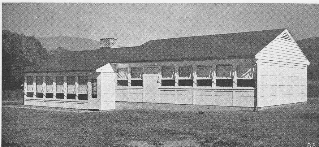
Bild 2. Bungalow im Staate New York, Durisol-Plattenbauweise mit Holzskelett, Architekt WILLY LESCAZE, New York
