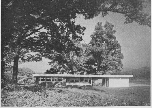
Bild 4, Landhaus bei New York, Durisol-Plattenbauweise mit Holzskelett
