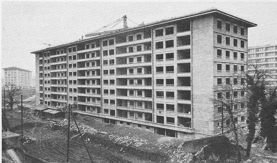
Bild 6. Neunstöckiger Wohnbau in Genf, skelettlose Ausführung mit tragenden Durisol-Mauersteinwänden, Architekt F. JENNY, Zürich
