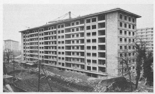
Bild 6. Neunstöckiger Wohnbau in Genf, skelettlose Ausführung mit tragenden Durisol-Mauersteinwänden, Architekt F. JENNY, Zürich
