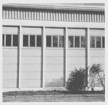
Bild 8. Industriebau in Wolfwil, Durisol-Plattenbauweise auf Eisenbetonskelett (vorfabriziert)
