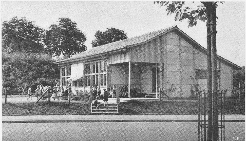
Bild 5. Kindergarten der Stadt Basel, Durisol-Plattenbauweise mit Holzskelett, Hochbauamt Basel-Stadt
