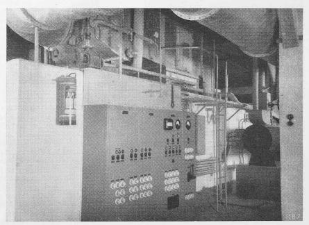
Bild 7. Klimakammer mit vorgebautem Schaltschrank. Ueber der Kammer sind die Luftkanäle mit eingebautem Luftwäscher sichtbar.
