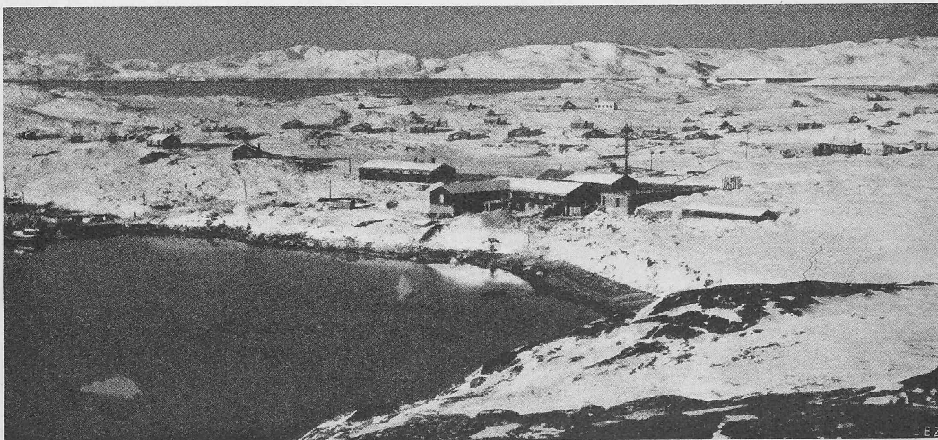
Bild 1. Durisol-Dorf in Grönland; Häuser in Durisol-Mauersteinbauweise ausgeführt.
