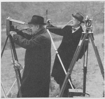
Bild 1. Der «Perspektograph» in zwei verschiedenen Ausführungen
