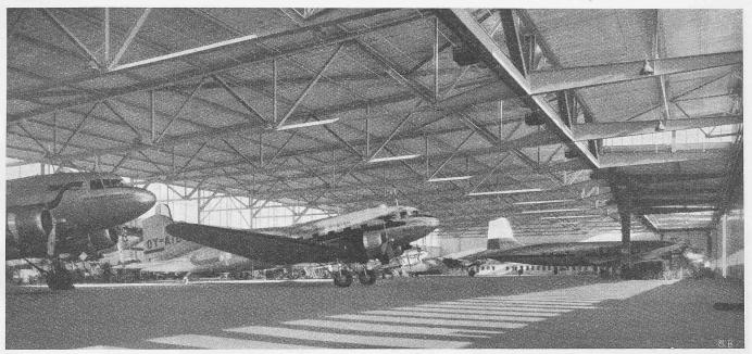
Bild 15. Die Flugzeughalle (geschweisste Stahlkonstruktion) auf dem Flughafen Bromma ist mit 9000 m² armierten Siporex-Dachplatten von  $0.5 \text{ kg/dm}^3$  Raumgewicht gedeckt und mit 3000 m² Siporex-Platten von  $\gamma = 0.4 \text{ kg/dm}^3$  isoliert
