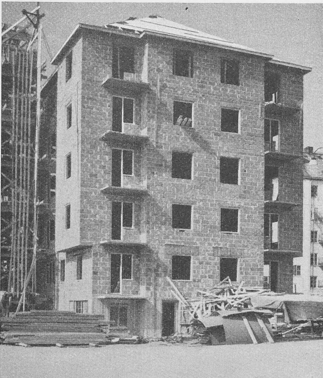
Bild 13. Fünfstöckiges Leichtbetonhaus aus Ytong-Mauerwerk. \gamma = 0,65 \text{ kg/dm}^3 , Druckfestigkeit des Leichtbetons 65 \text{ kg/cm}^2 , Zul. Druckspannung des Mauerwerkes 6 \text{ kg/cm}^2 , Sicherheitsgrad \sim 5 .
