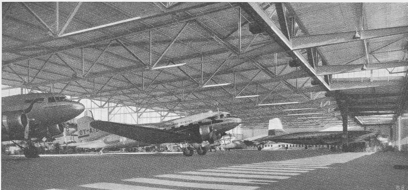
Bild 15. Die Flugzeughalle (geschweisste Stahlkonstruktion) auf dem Flughafen Bromma ist mit 9000 m 2 armierten Siporex-Dachplatten von 0,5 kg/dm 3 Raumgewicht gedeckt und mit 3000 m 2 Siporex-Platten von \gamma = 0,4 kg/dm 3 isoliert
