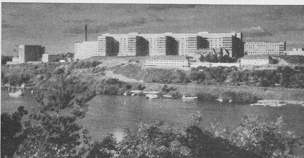
Bild 19. Das Südspital in Stockholm, Schwedens grösstes und modernstes Krankenhaus (1200 Betten), wurde nach umfangreichen Vergleichsversuchen über die Frostbeständigkeit und Putzhaftfähigkeit verschiedener Baustoffe vollständig mit Siporex-Platten von 0,4 kg/dm 3 Raumgewicht isoliert (60000 m 2 ). Für das Dach wurden 5400 m 2 armierte Dachplatten mit \gamma = 0,5 kg/dm 3 verwendet.
