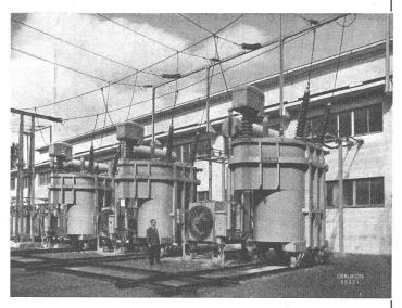
Drei Einphasentransformatoren, 38 000 kVA, Nennspannung 150/50/8 kVA, in Gruppe, von der Oberspannungsseite aus gesehen. Kraftwerk Benznau.
