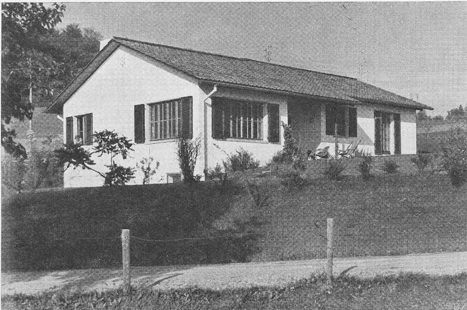
Bild 7. Ansicht aus Süden
