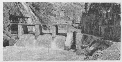
Bild 5. Umgebautes Wehr mit Wasserfassung auf dem rechten Ufer.
