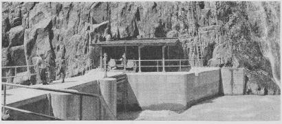
Bild 6. Wasserfassung am rechtsufrigen Ende des umgebauten Wehres.
