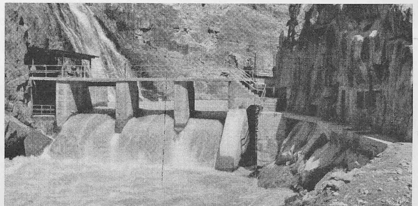
Bild 5. Umgebautes Wehr mit Wasserfassung auf dem rechten Ufer.
