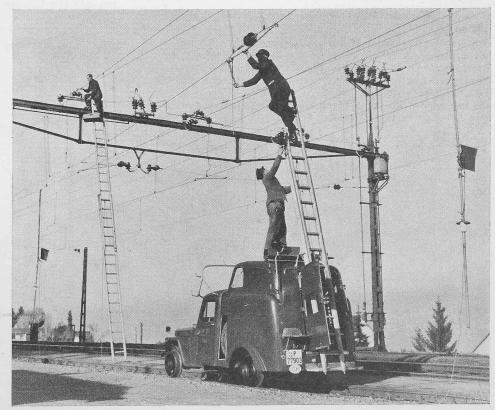
Bild 7. Der Motorwagen als Arbeitsfahrzeug
