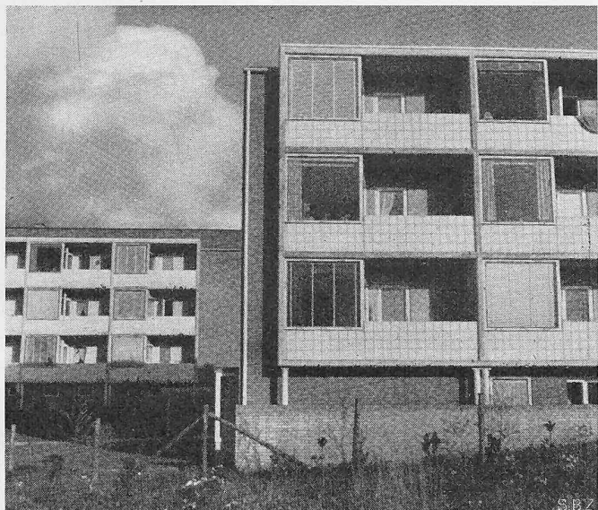
Bild 25. Gentofte, Fassadendetail. Kontrast von Backstein und Beton, Fläche und Balkonöffnung.
