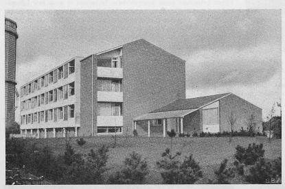
Bild 23. Wohnungen für junge Ehepaare in Gentofte. Scharfe Konturen, hervorgerufen durch Weglassen der Dachvorsprünge. Rechts der Kindergarten,
