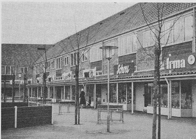
Bild 32. Sondergard Park, Hauptzugang zur Siedlung mit verschiedenen Läden.
