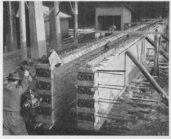
Bilder 19 und 20. Brücke über das Hilfswehr des Kraftwerks Wildegg-Brugg, Vorgespannte Trägerrippen  $0.41 \times 1.2$  m, als vorfabrizierte Träger am Ufer hergestellt. Total 4 Oeffnungen mit je 23 m Spannweite. Projekt: Ing.-Bureau E. Schubiger, Zürich.
