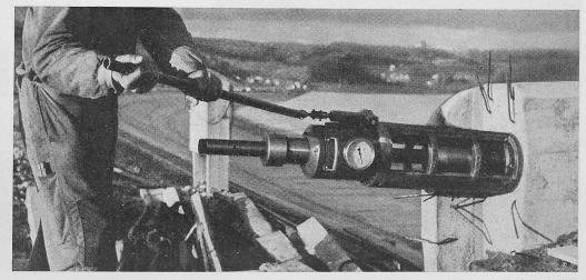
Bild 4. Zylindrischer Stützbock und Vorspannpresse beim Vorspannen
