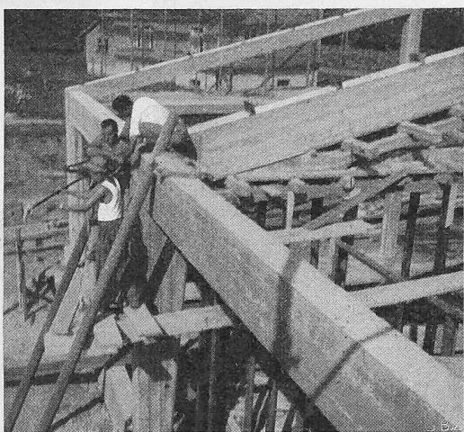
Bild 25. Fabrikneubau in Müntschemier. Vorgespanntes Zugband für dreieckförmige Hallenbinder mit 20 m Spannweite, Vorspannkraft 40 t pro Zugband. Projekt: Ing.-Bureau Hartenbach & Wenger, Bern.
