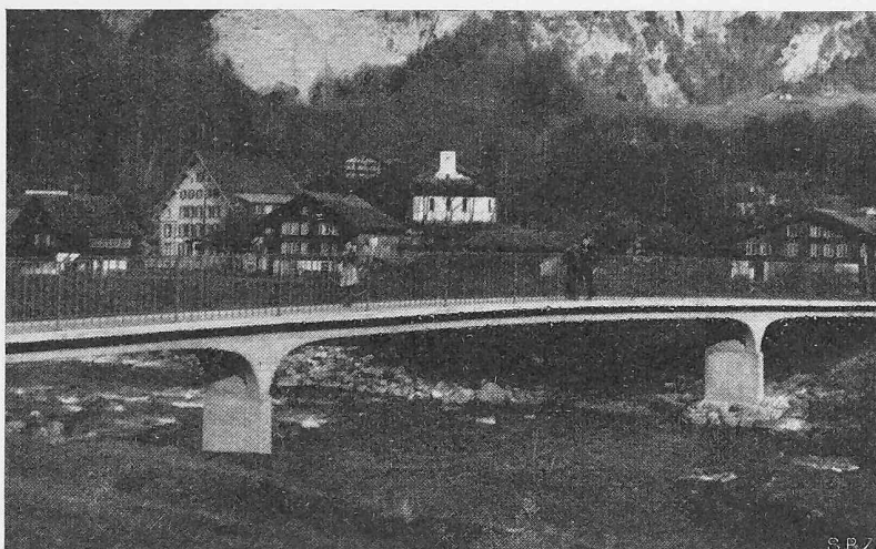
Bilder 17 und 18. Aaresteg bei Innertkirchen, Kontinuierlicher Plattenbalken, Spannweiten 11,5+19,5+11,5 m, Trägerhöhe in Feldmitte 0,48 m, Vorgespannt mit 4 Kabeln mit je 60 t Vorspannkraft, Projekt: Obering. J. Bächtold, Innertkirchen und Ing.-Bureau M. R. Ros, Zürich
