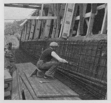
Bild 28. Weberei Boller, Winkler & Cie. in Turbenthal. Schalenshed mit 30 m Spannweite, Vorspannung der Fensterträger mit je 2 Kabeln zu 80 t. Projekt: Ing.-Bureau A. Sabathy, Winterthur.
