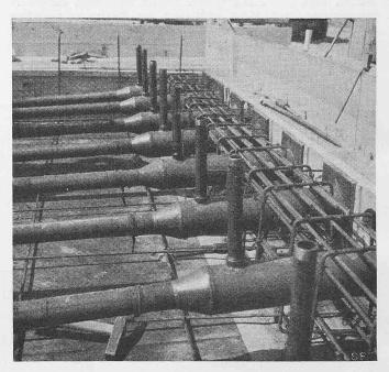
Bild 7. Vorspannarmierungen der Brücke Bild 6 mit Unterlagsplatten und Uebergangsrohren und ihren Injektionsstutzen
