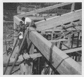
Bild 25. Fabrikneubau in Müntschemier, Vorgespanntes Zugband für dreieckförmige Hallenbinder mit 20 m Spannweite, Vorspannkraft 40 t pro Zugband, Projekt: Ing.-Bureau Hartenbach & Wenger, Bern.
