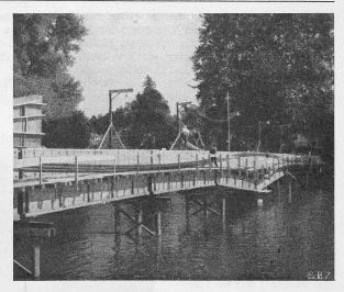
Bilder 23 und 24. Aaresteg bei Aarau. Kontinuierlicher Plattenbalken über 3 Felder, Spannweiten 34,0 + 41,0 + 34,0 m, Brückenstärke in Feldmitte 1,25 m, totale Vorspannkraft 450 t. Projekt: Ing.-Bureau E. Schubiger, Zürich.
