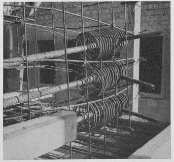
Bild 29, Neubau Kantonsspital Schaffhausen, Ueberzüge im Dachraum, Spannweite 18,0 m. Totale Vorspannkraft 3 × 55 t. Spiralarmierung unter der Unterlagsplatte zur Verbesserung der Krafteinleitung. Projekt: Ing.-Bureau A. Wildberger, Schaffhausen.
