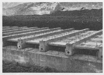
Bild 33. Bachüberdeckung in Unterbach bei Meiringen. Vorfabrizierte vorgespannte Träger L = 6,0 m, jeder mit einer runden Aussparung, durch welche eine Vorspannarmierung 45 t durchgeschoben wurde. Zwischen den Trägern liegen vorgespannte Betonplatten, über die ein Aufbeton von 15 cm gegossen wurde. Projekt: Ing.-Bureau E. Nil, Meiringen.
