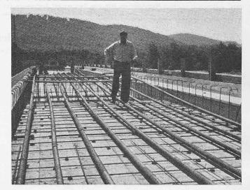
Bild 6. Vorspannarmierungen 80 t in einer Strassenbrücke verlegt
