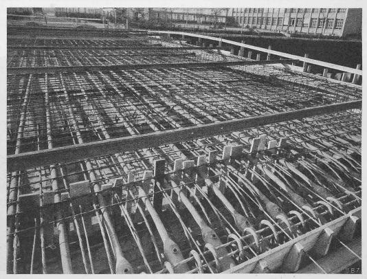
Bild 31. Marschalkenbrücke in Basel Rahmenkonstruktion, bestehend aus 2 Flügelmauern in Eisenbeton und einem vorgespannten Riegel, als Massivplatte ausgebildet. Plattenstärke in Feldmitte 0,40 m, Fahrbahnbreite 9,00 m, totale Vorspannkraft in Längsrichtung 2200 t, in Querrichtung 1100 t. Projekt: Ing.-Bureau E. Schmidt, Riehen/Basel.
