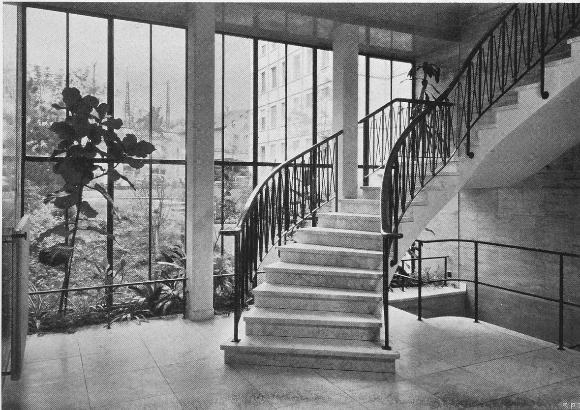
Treppenantritt im Haus Avenue de la Gare
