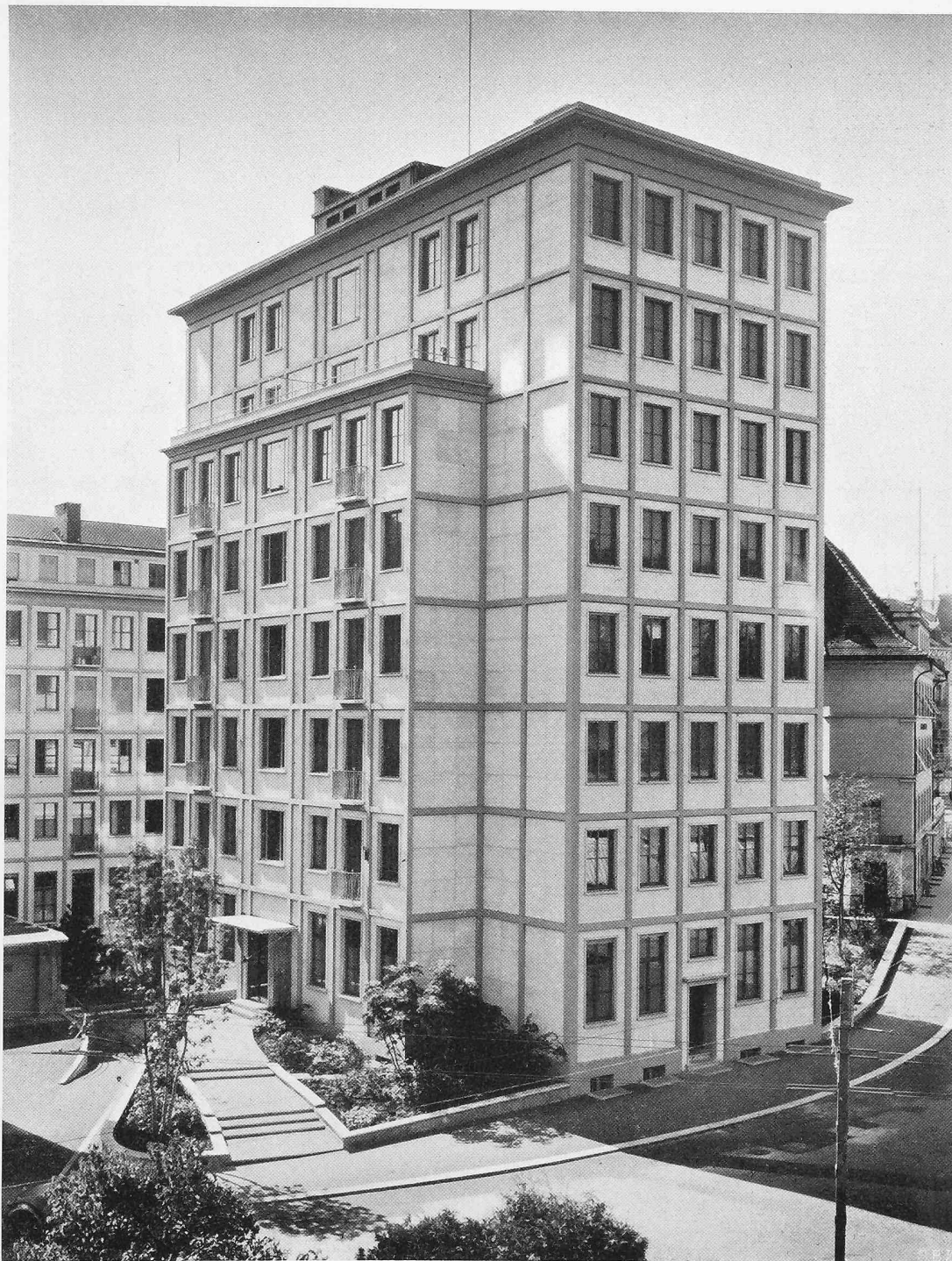
Das Gebäude an der Rue de Tivoli, Nordostseite mit Eingang und Küchenbalkonen
