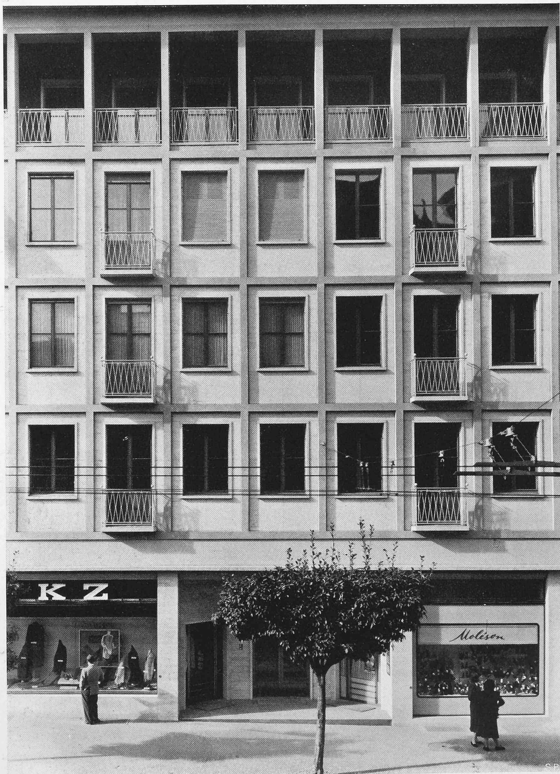
Ausschnitt der Fassade an der Avenue de la Gare
