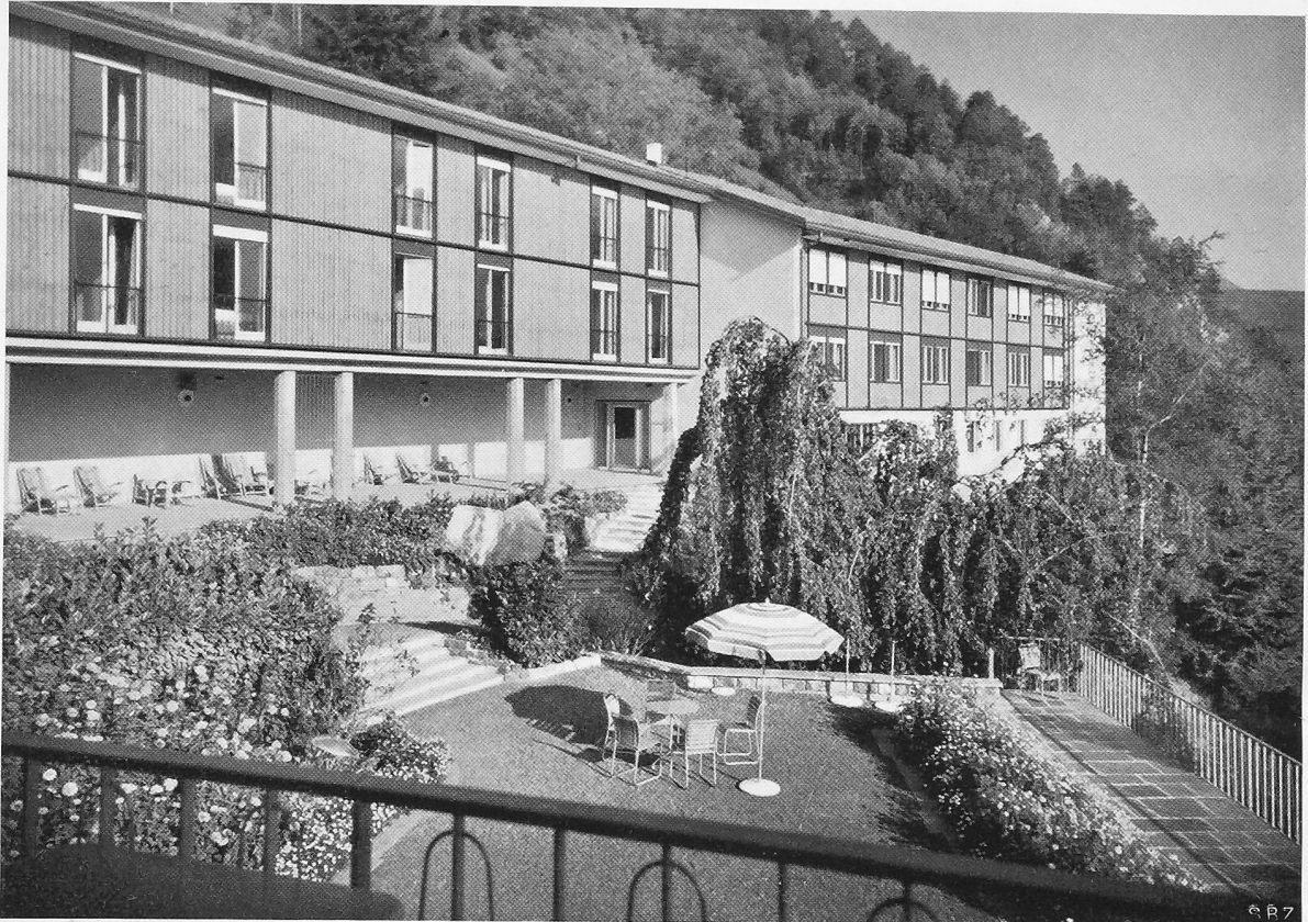
Bild 24. Die Bettenhäuser von der Speisesaal-Terrasse aus gesehen
