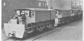
Lokomotiven mit NIFE-Stahlakkumulatoren
