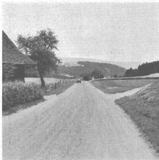
Strasse mit Bodenvermörtelung
