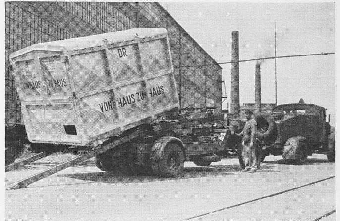
Bild 8. Zugmaschine mit Spezialanhänger der Weser AG. Bremen beim Verladen.
