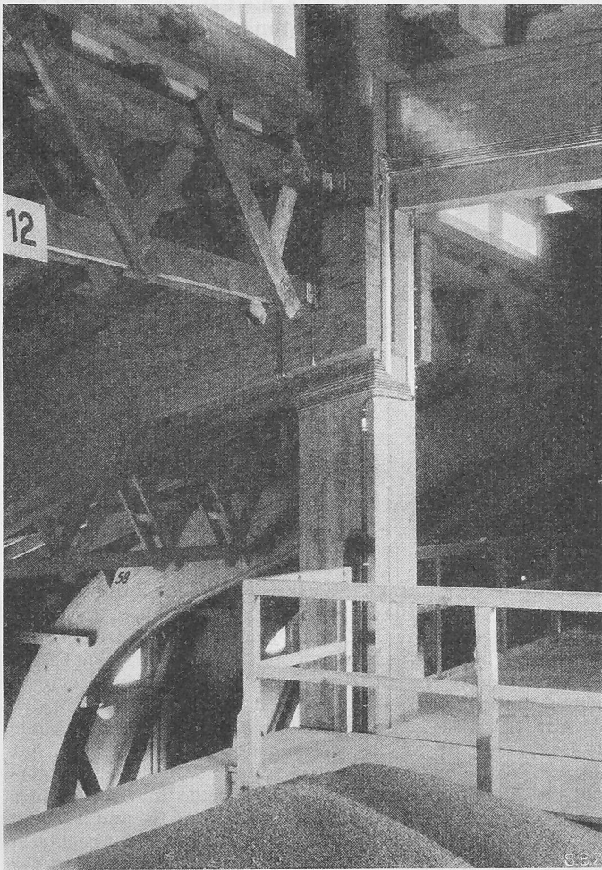
Bild 9. Elevatorenturm; Pfosten mit Anschluss des Binders und der Gitterpfetten. Oben rechts Hetzerbalken 18 \times 75 cm (vgl. Bild 6, Seite 53)
