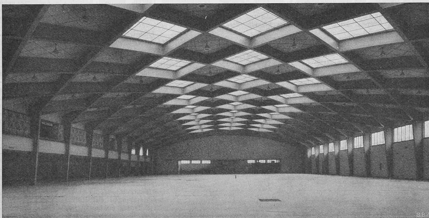
Die fertige Halle. Vollständig geschweisste Stahlkonstruktion; Zweigelenkrahmen von 43,47 m Spannweite. Ing. M. COSANDEY, Lausanne
