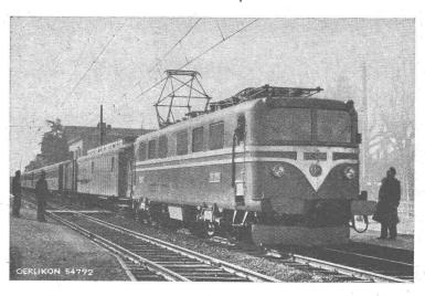
CoCo-Lokomotive No. 6051 der Société Nationale des Chemins de fer Français (S. N. C. F.) für Einphasenstrom 50 Per./s, 20 KV, Stundenleistung 4300 PS, mit Schnellzug auf der Strecke Aix-les-Bains-Annecy. Diese Lokomotive hat bisher 120 000 km zur vollen Zufriedenheit der S. N. C. F. bewältigt.
